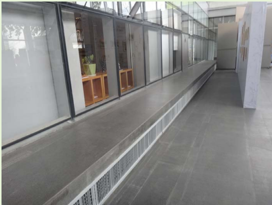
下吹式新鮮空氣送風口，其對應之熱空氣回風口設置於 1.2 米高處。
